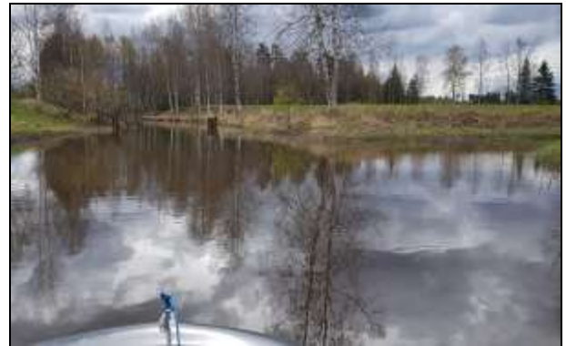
Kuva 106. Kohdassa 33,6 km on näkyvissä vanhan sillan puiset pilarit. Kuvan oikeassa laidassa on joen haara. (Y)
