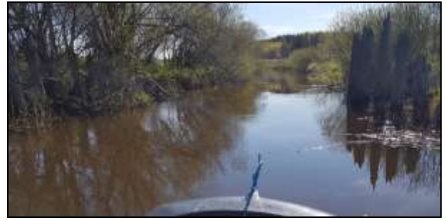
Kuva 80. Vanhan sillan paalut (22,95 km A).
