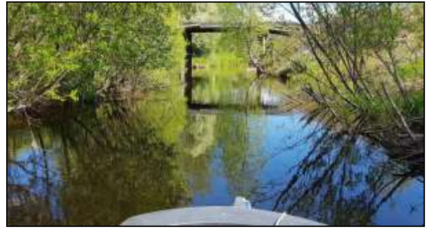
Kuva 23. Silta (6,2 km A).
