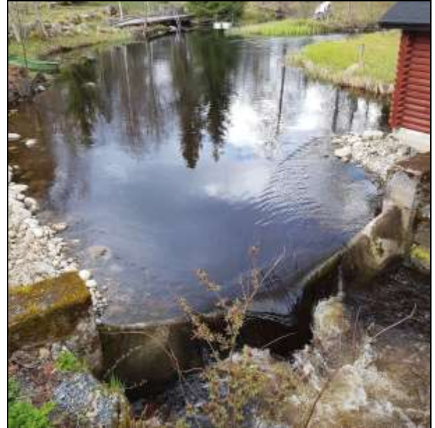
Kuva 7. Jokelankosken padon (1,45 km Y) eteläinen haara. Vastaava pato on oikealla näkyvän rakennuksen pohjoispuolella.
