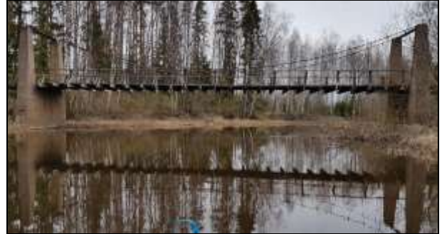
Kuva 168. Kiehonkoskella (20,3 km Y) oleva silta ylävirtaan kuvattuna.
