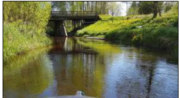
Kuva 38. Koskelantien sillalle tulossa virran tuomana (12,0 km A).
