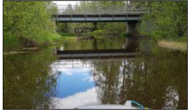
Kuva 61. Edessä Myllykylän silta ja sen jälkeen pato (17,9 km A).
