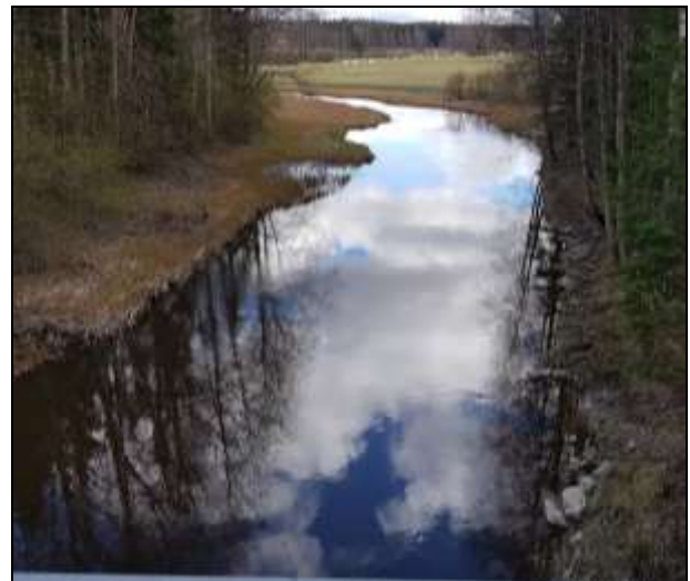
Kuva 142. Näkymä Varunteenkosken sillalta (7,5 km Y) ylävirran suuntaan.
