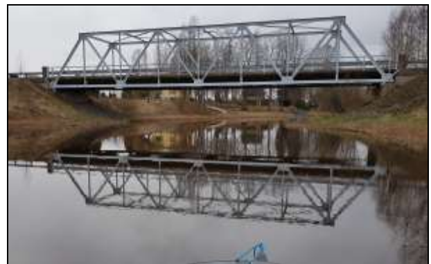
Kuva 180. Kolmilammintien ristikkosilta alavirtaan kuvattuna (25,8 km A).
