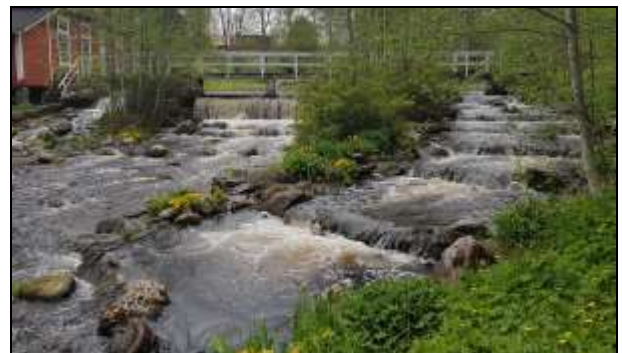
Kuva 12. Pellavaloukun pato alapuolelta kuvattuna (Y).
