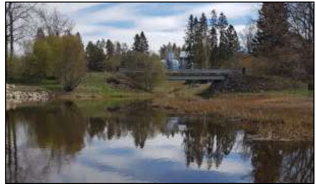
Kuva 153. Puujaan silta myötävirtaan kuvattuna (10,75 km A).
