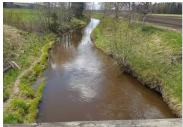
Kuva 75. Näkymä alavirtaan Teuronjoentien sillalta (A).
