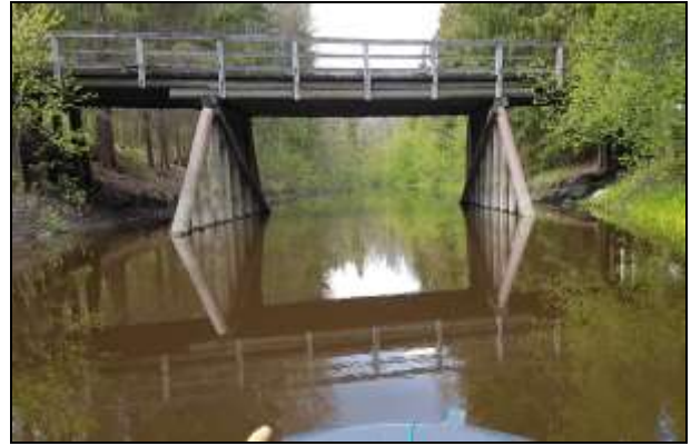
Kuva 92. Koskipääntien silta (27,25 km A).
