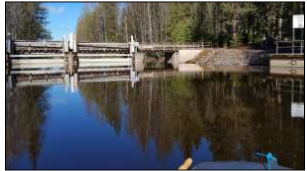
Kuva 133. Vuolteenkosken pato ja silta (4,15 km A) ylävirran puolelta.
