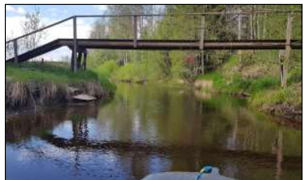
Kuva 30. Kävelysilta (9,45 km Y).
