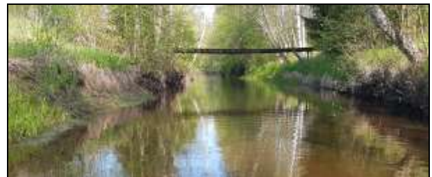
Kuva 29. Kävelysilta (9,2 km Y).
