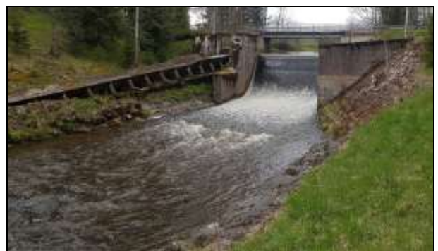
Kuva 63. Myllykylän pato alhaalta päin kuvattuna (Y).
